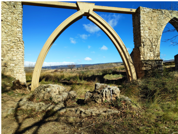
Figura 1: Detalle del pilar del puente romano a los pies del Acueducto de Los Arcos, Barranco Reguero de Alpuente.
